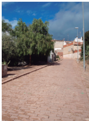
Tramo ya recuperado.
